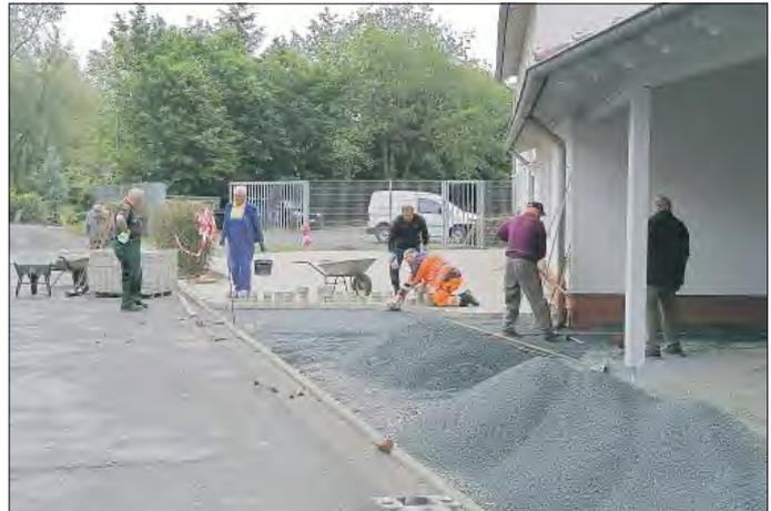
Ausbaggern, Beton ab stemmen, Randsteine entfernen, neue Randsteine setzen, Schotter verteilen, Feinsplitt auftragen und schließlich 340 m<sup>2</sup> verlegen, da war doch so manche helfende Hand nötig.
